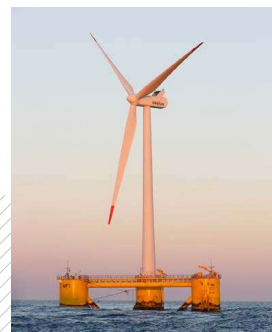
Figure 3 : Prototype d'éolienne flottante mise en service au Portugal par EDPR (source : EDPR)
