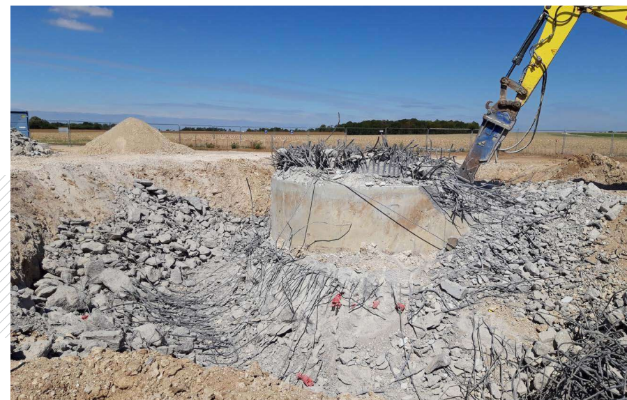
Figure 79 : Démantèlement des fondations d'une éolienne sur un parc EDPR (source : EDPR)
